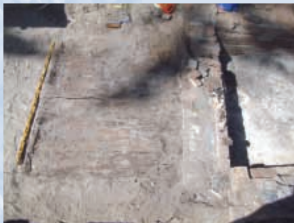
Houten vloer aan oostzijde van het waterbekken.
