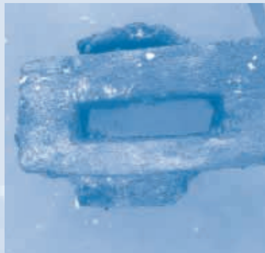
Detail van de westelijke palenrij van de houten brug: paal met slof
