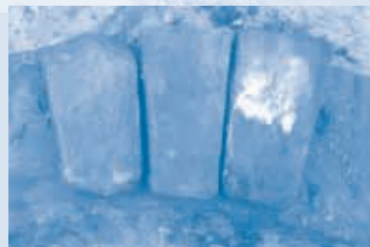
De trapezium-vormige bakstenen van de put
